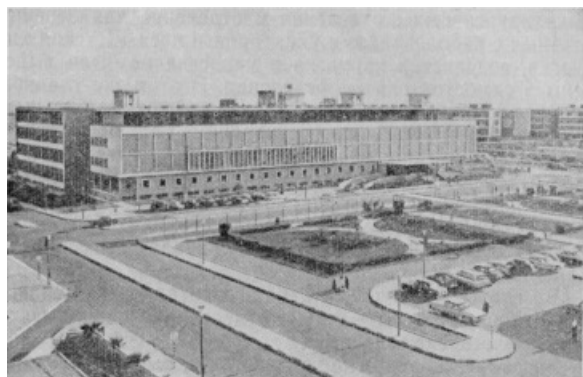
Главный хирургический корпус Ас-Сабах-госпиталя
