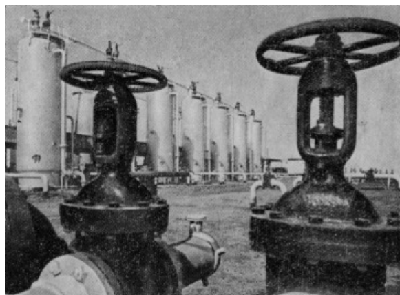
Нефтеборный пункт (центр), где нефть отделяют от газа, который тут же сжижают
